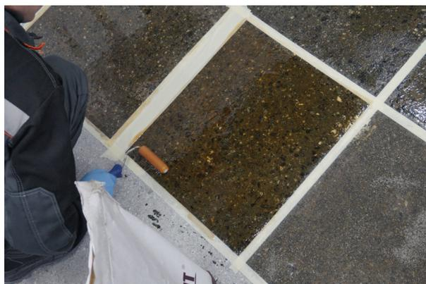
Поверхность должна быть полностью загрунтована. Если поры бетона останутся открытыми – визуально наблюдаются непрокрашенные участки, то воздух, выходящий из них, может вызвать нарушение целостности поверхности свеженанесенного жидкого полимера.
