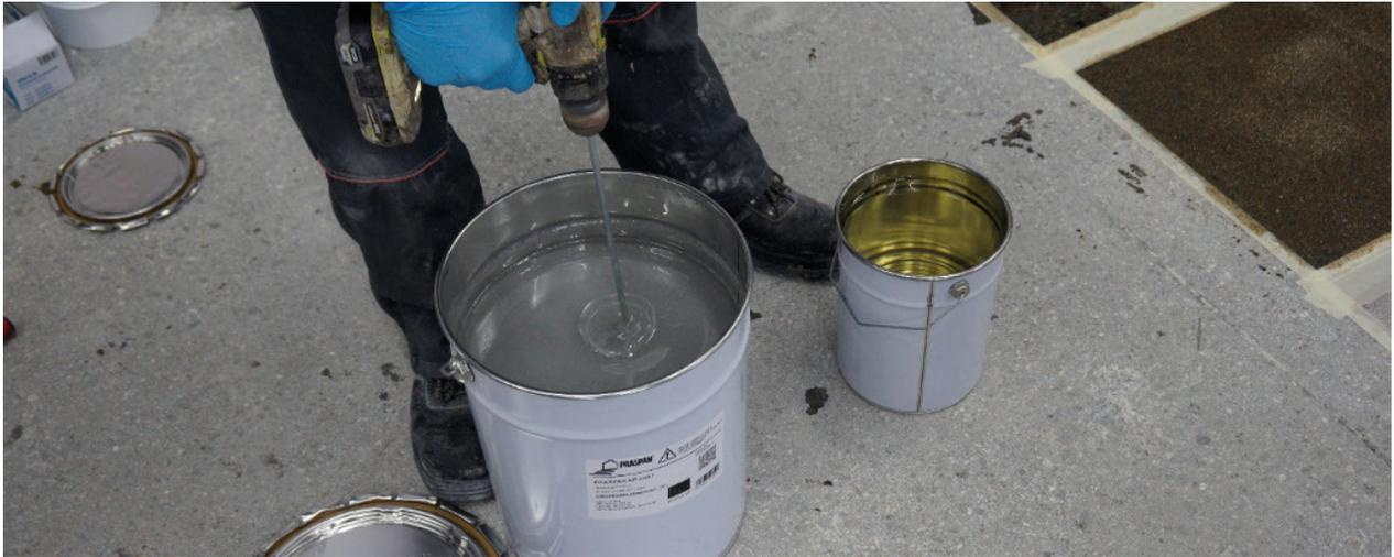
2. Перелить пигмент (предварительно перемешать пигмент деревянным шпателем) в емкость с компонентом А. Перемешать с помощью миксера в течение 2 минут.
