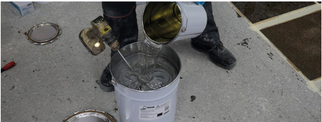
Протекающие реакции идут с выделением тепла, поэтому смесь саморазогревается в объёме (ведре) материала и процесс полимеризации ускоряется. Из этого следует, что время жизни материала в объёме и на поверхности значительно отличается и простой в ведре существенно ограничивает время на обработку материала.
